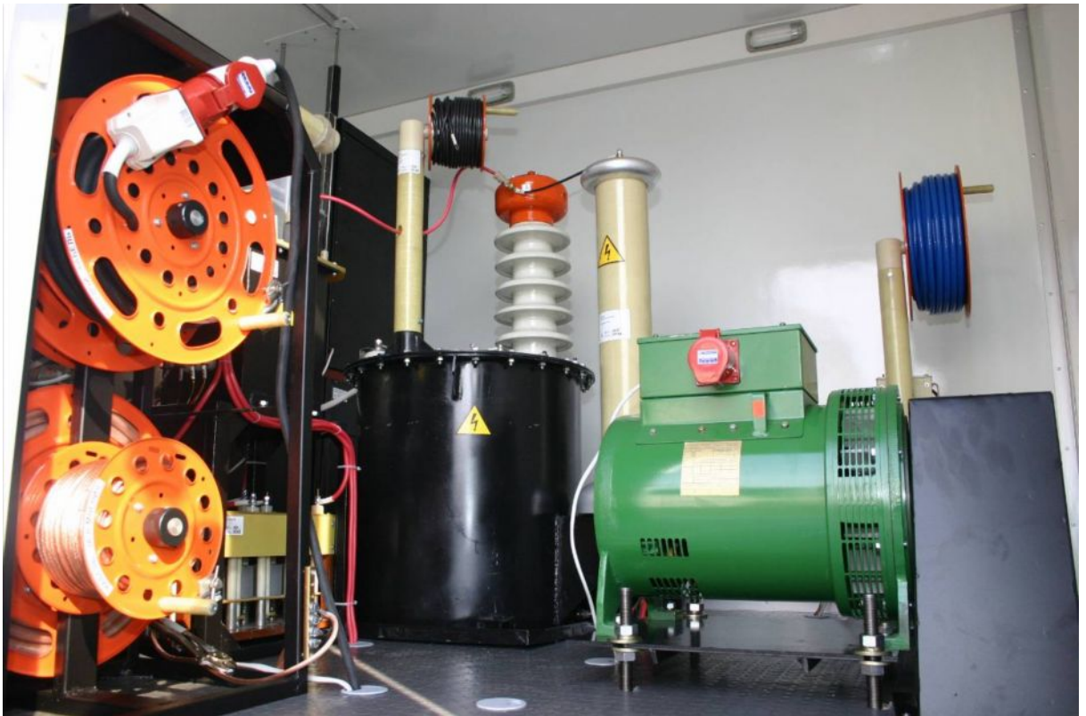
Вид на высоковольтный отсек лаборатории ЛВИ НВТ -2G на базе ГАЗ-3308
