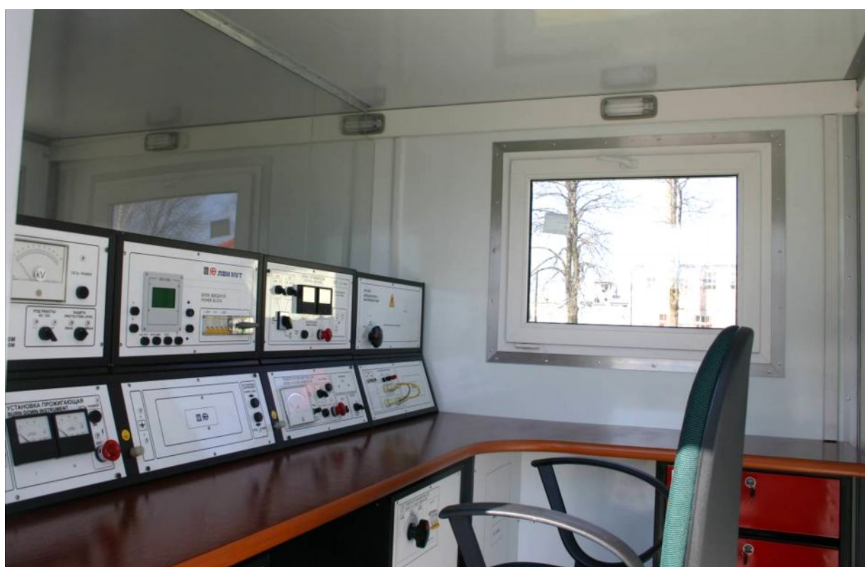
Вид на отсек оператора лаборатории ЛВИ НVT -2AG на базе ГАЗ-3308
